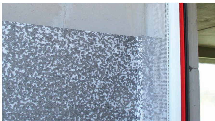
Membrane Duo avec grille pour raccordement à l'Isolation Thermique par l'Extérieur (ITE)
