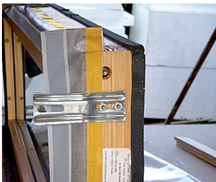
Installation de l'illmod 600 et de la membrane Duo au pourtour de la menuiserie
