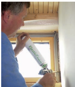
Extrusion de la mousse expansive élastique illbruck par un applicateur de la société LCA
