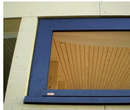
Vue de l'extérieur
