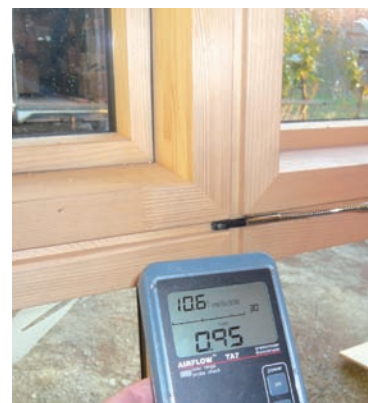
Mise en évidence d'un défaut d'étanchéité entre dormant et ouvrant de la menuiserie
