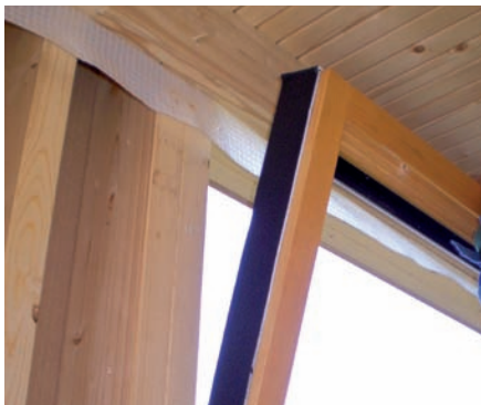
Mise en place
