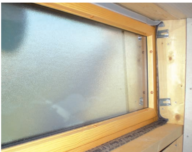
Membrane Duo en attente pour raccordement ultérieur au pare-vapeur intérieur
