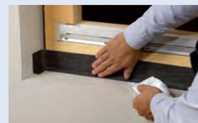
**Fenêtre posée en tunnel**
