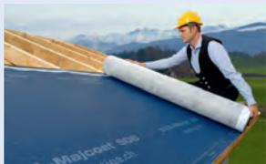
**Montage d'un écran de sous-couverture avec adhésif intégré**
