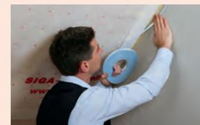
**Frein-vapeur sur mur de construction massive**
