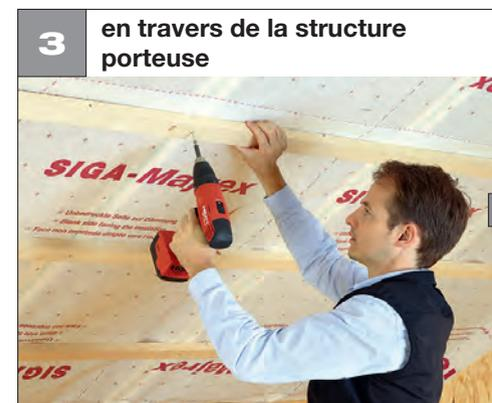
**3 en travers de la structure porteuse**
