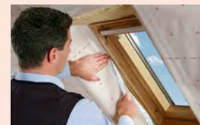
**Raccordement d'une fenêtre de toit**
