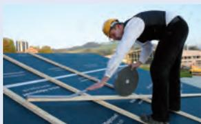
**Montage de la bande d'étanchéité pour clous**
