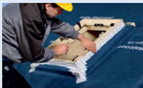
**Raccordement d'une fenêtre de toit**
