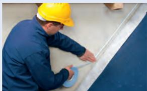
**Raccordement d'un écran de sous-couverture sur une construction massive**
