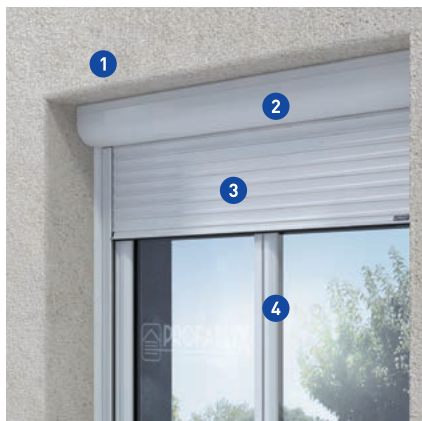
Sous linteau enroulement vers l'extérieur
