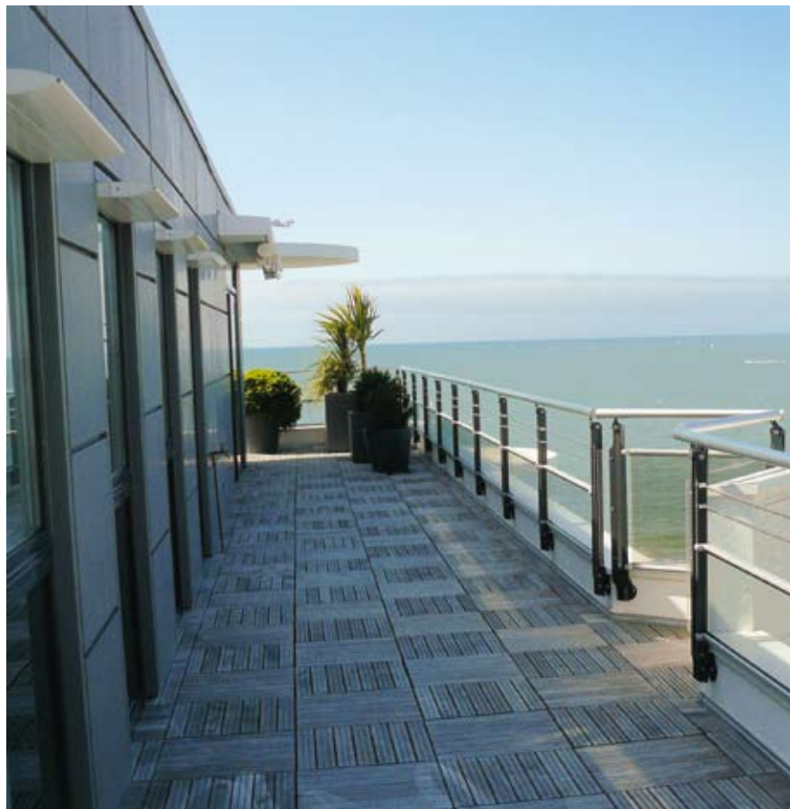
Le Mariza - Architectes: J.P.BLANCHARD, Y.DESRUES, F.GELLARD
