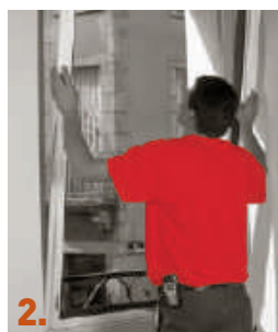
2. Mise en place de la nouvelle menuiserie.
