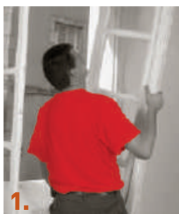
1. Dégondage des ouvrants.
