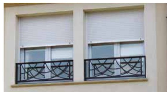
Main courante 50 x 25 mm arrêtes arrondies
