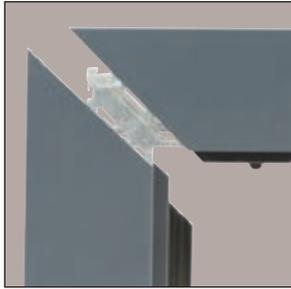
Assemblage dans les angles à l'aide d'équerres
