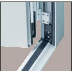
Seuil PMR à rupture de pont thermique
