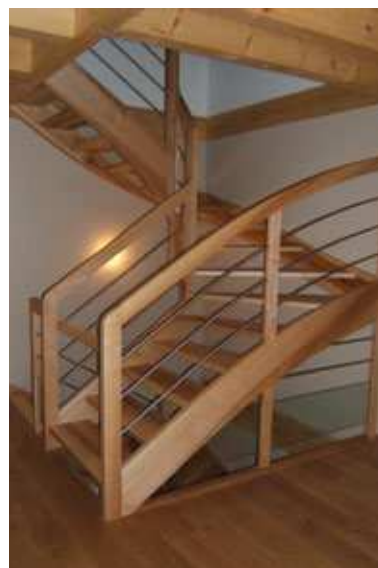
▲ Escalier 2/4 tournant à limons Frêne Olivier vernis naturel Garde de corps sous limon (lisses inox 16 mm et vitrage stadip clair 44/2) Garde corps rampant, lisses inox 16mm
