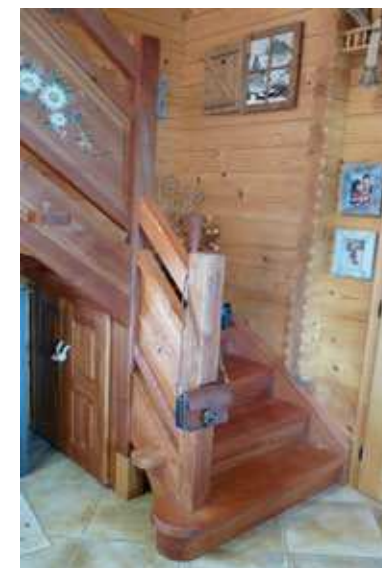
▲ Escalier ¼ tournant style alpin en mélèze Garde corps rustique sculpté et peinture décorative L'ensemble de l'escalier est brossé
