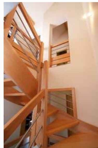
Escalier 2/4 tournant à palier intermédiaire Hêtre vernis naturel, garde corps rampant 3 câbles inox, garde corps horizontaux 3 câbles inox et vitrage stadip 44/2 clair
