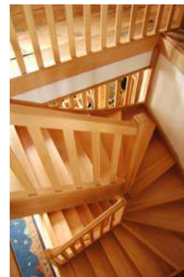
▲ Escalier 2/4 tournant avec une claustra Hêtre vernis naturel Poteau N°2, main courante N°2, balustre N°2 Demi habillage de trémie
