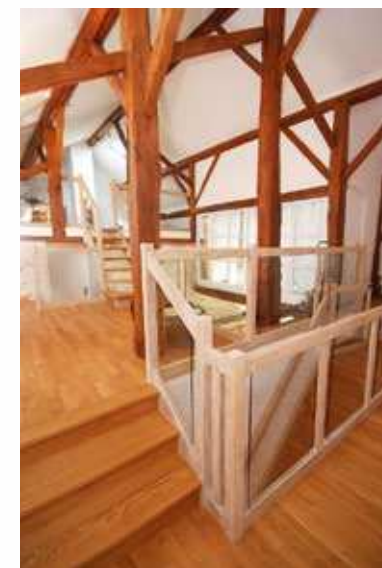
Plusieurs escaliers en chêne Marches vernis naturel + garde corps cérusé blanc + vernis Vitrage stadip 44/2 clair
