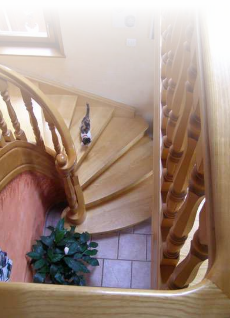
Escalier 2/4 tournant à limon et garde corps débillardés Frêne vernis naturel, volute au départ de l'escalier, balustres TS
