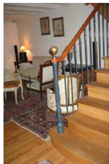
Escalier 1/4 tournant à crémaillères intérieures Chêne vernis naturel, Main courante chêne teinté + vernis Profil des marches à « Bec de Corbin » Poteau de départ forgé et peint + boule en laiton Balustres mp4 à une seule bague
