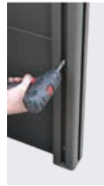
Vissage du poteau
